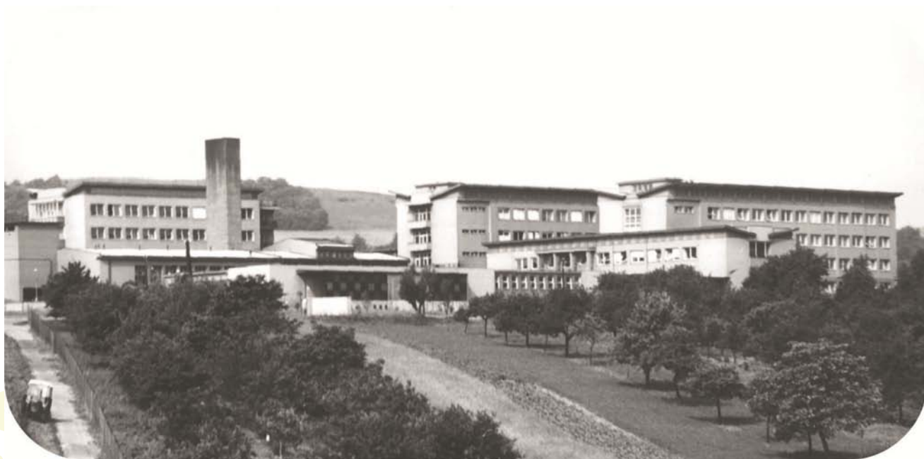
Celkový pohled na ústav rok 1963
